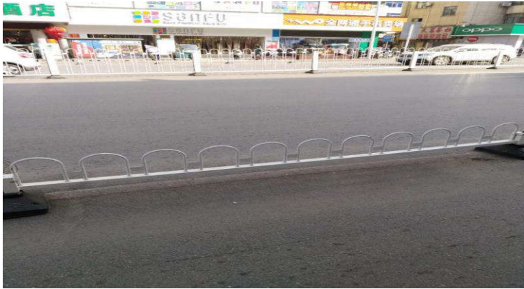
(26) 伸缩移动护栏：不锈钢材质，高 70 厘米。
